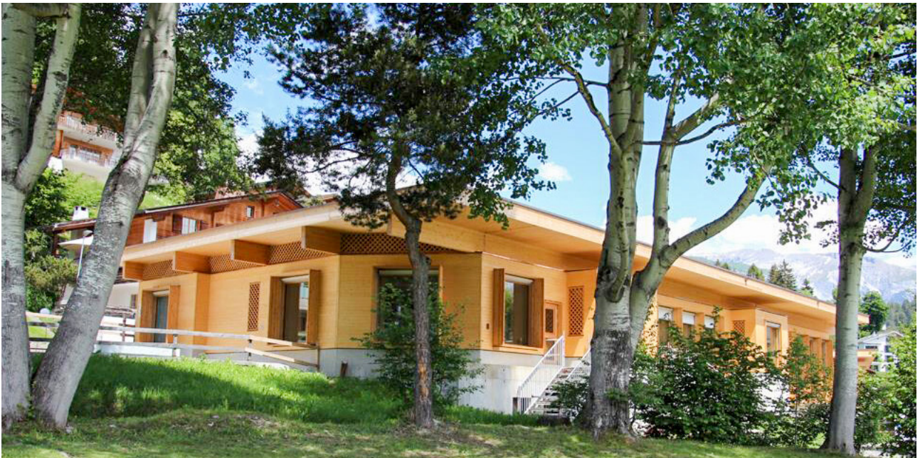
Die Kinder der Gemeinde Laax besuchen den Kindergarten im neu errichteten Gebäude am Laaxersee.
